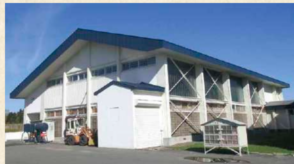
「柏の里デイセンター」体育館
